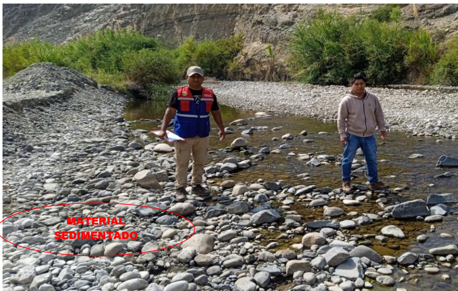
FIGURA N°02: MATERIAL COLMATADO EN EL CAUCE DEL RÍO HUARMEY, CON UNA PROFUNDIDAD PROMEDIO DE 1.0 M. ESTO PROVOCA QUE DESBORDAMIENTO DEL RÍO SEA MAS INMINENTE.
